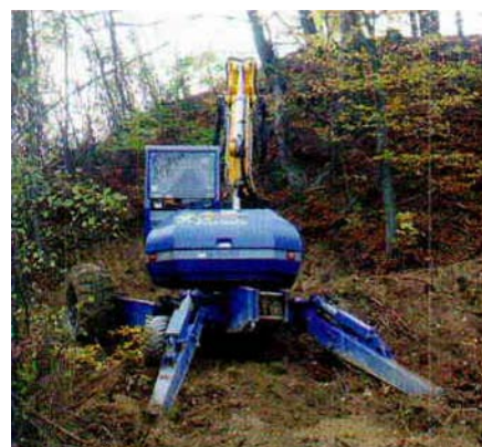
„Excavatorul păianjen” poate lucra chiar și pe teren dificil.
