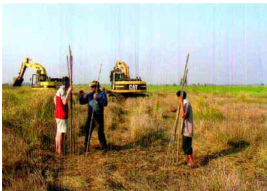
Conturul literelor este marcat cu bețe, astfel încât să poată începe săpatul cu excavatorul.
