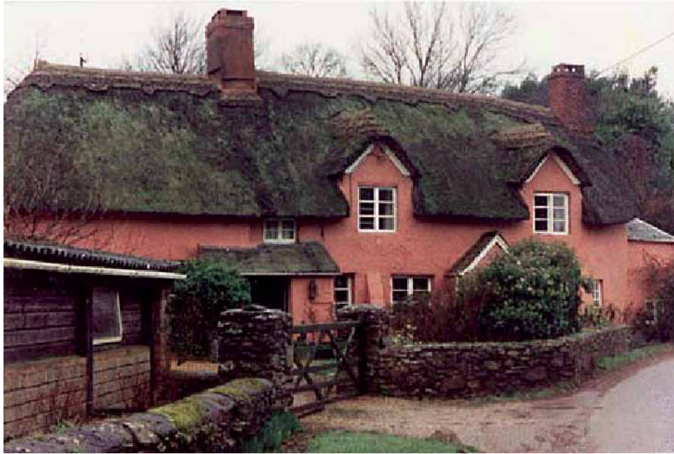
Trei exemple de clădiri de cob care au rezistat timp de câteva secole în sud-vestul Angliei.
