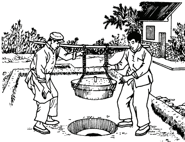
Fig. 4 -23. Fixarea capacului detașabil
