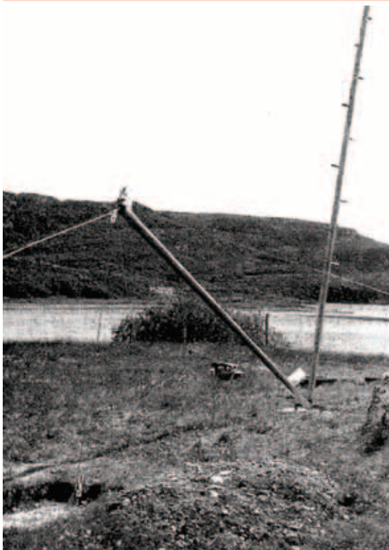
Un scripete pe o capră și un turn înclinat de 12 m
