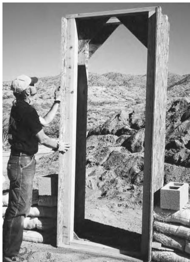
2.25: Un cofraj deschis, tip stâlp de mină, permite accesul liber în incintă fără a trebui să se escaladeze zidurile în timpul construcției.
