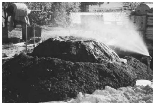
2.8: Pregătirea materialului pentru construcția zidului, prin folosirea unui furtun pentru a pre-umezi o grămadă de pământ.
