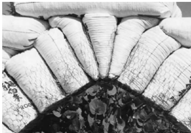
3.23: Este mai bine să ai un spațiu mai îngust pentru cheile de boltă, pentru a încăpea mult mai bine, decât unul prea larg.
