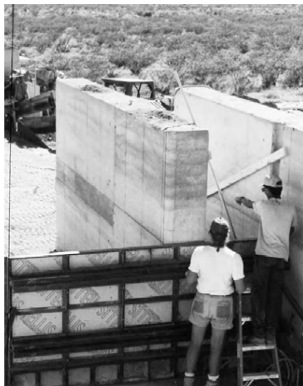
1.6: Zid de pământ compresat după îndepărtarea matrițelor.
