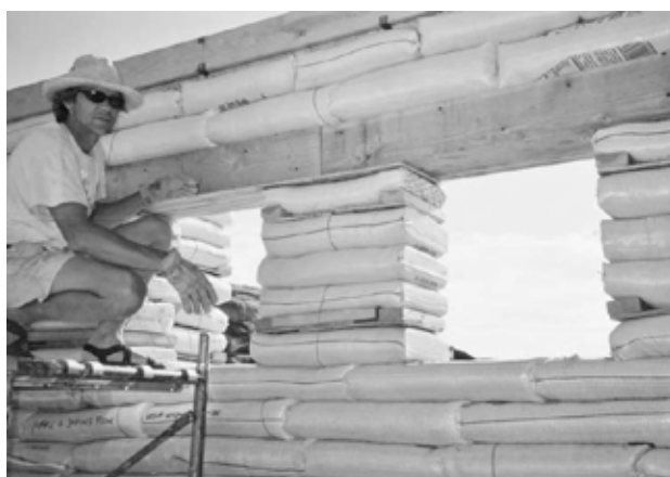
8.3 (deasupra): În proiecte cu ferestre multiple, se pot împărți plăcile Velcro, sau buiandrugul se poate întinde deasupra tuturor ferestrelor.
