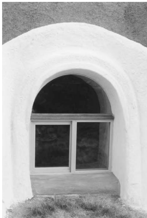
8.4: Frumusețea unei ferestre arcuite este dată de faptul că forma este atât atractivă, cât și structurală. Alegem arcul roman (semicerc) pentru majoritatea caselor, deoarece este cea mai simplă formă în care se pot crea ferestre funcționale.
