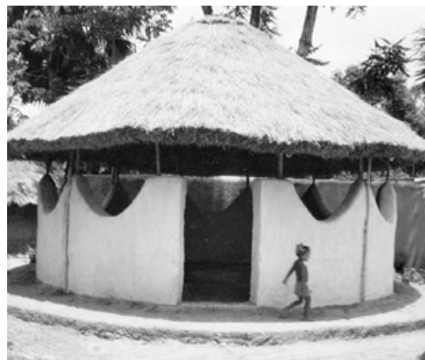
9.32: Cu acoperișul său din paie și cu structura sa din grinzi, stâlpi și umplutură de pământ, casa Baul din Baulkutir, India, se integrează natural în mediul și comunitatea pe care o servește.
