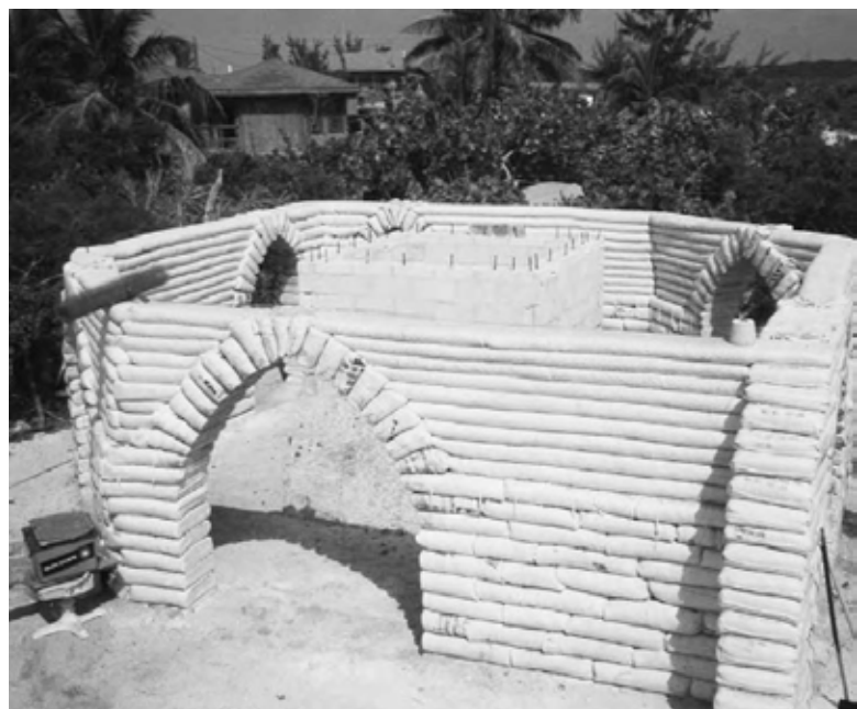
2.13: Sacii de 50 kg și cei mult prea mari pot fi, de asemenea, folosiți pentru cadrele ușilor și ale ferestrelor, în combinație cu sacii/tuburile de 25 kg folosite la ziduri.
