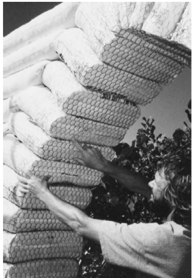
2.34: Suporturile au pe partea de jos a arcelor un substrat ideal pentru aplicarea tencuiei.
