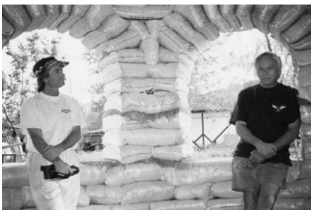
2.24: După îndepărtarea formelor. La pereții rotunzi, coloanele dintre deschiderile ferestrelor iau o formă frumoasă, trapezoidală.
