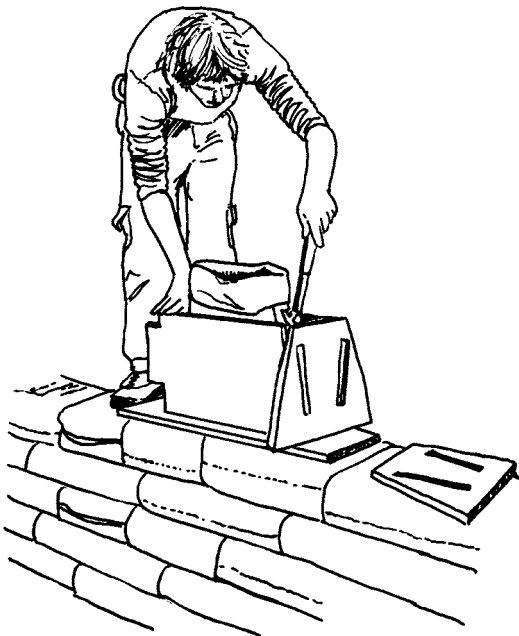
3.21: Capetele cutiei pană sunt îndepărtate, iar laturile cad pentru o îndepărtare ușoară a sacilor evantai prebătătoriți.
