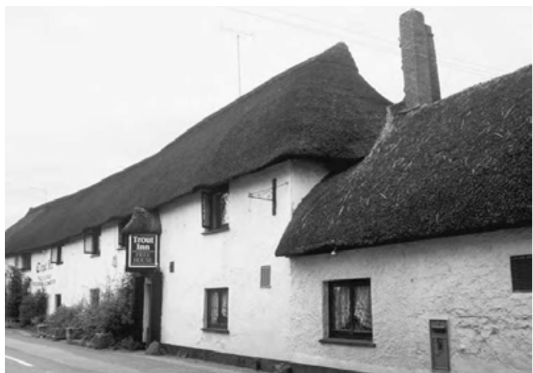
1.7: Exemplu de structură istorică din cob; Hanul Păstrăvului din Marea Britanie.
