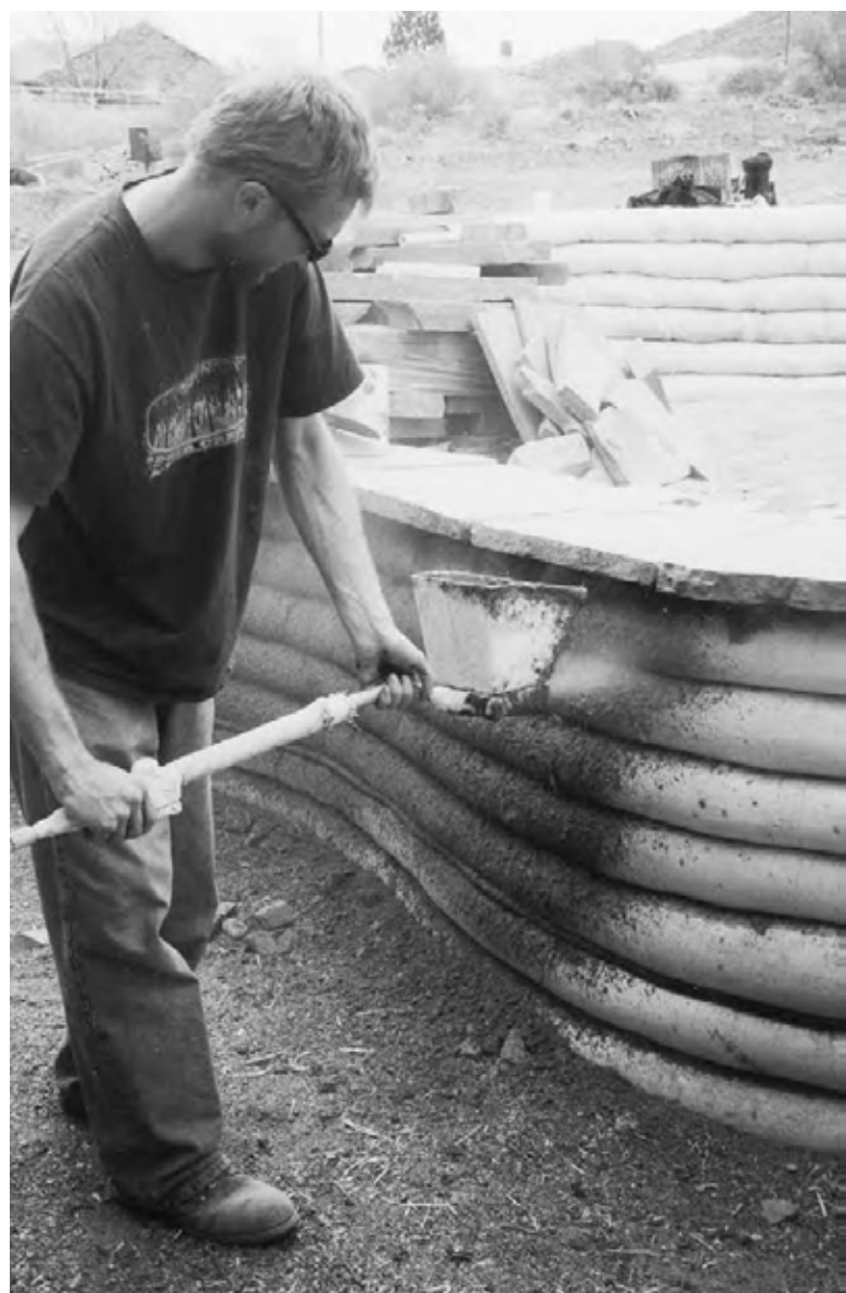
14.9: Pulverizarea nămolului pe un perete din saci cu pământ cu ajutorul unui pulverizator de tencuială.
