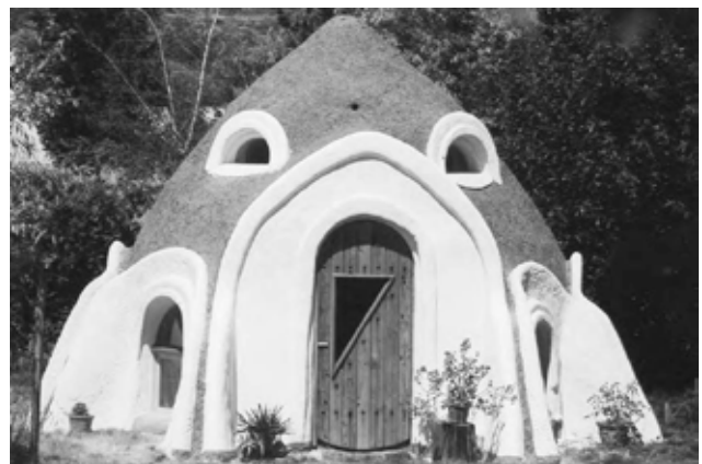
1.1: Folosind saci de pământ se poate ridica, dintr-un singur material de construcție, o întreagă casă, de la fundație la pereți și până la acoperiș.
