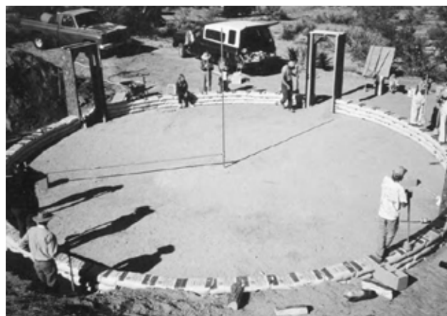
3.41: O casă de tip kiva, cu diametrul de 10,97 m, construită din saci cu pământ în Wikieup, Arizona.
