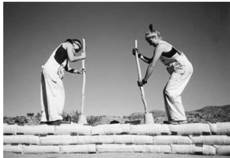
3.12: Rândul este bătătorit de deasupra până când pământul trece de la a face un sunet înăbușit, la un sunet răsunător distinctiv.
