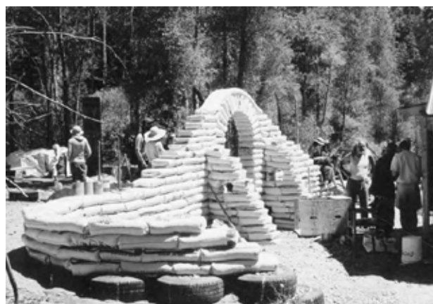
4.13: Fundația/socul menit să susțină un perete din saci cu pământ la workshop-ul din Rico, Colorado, despre clădiri naturale.
