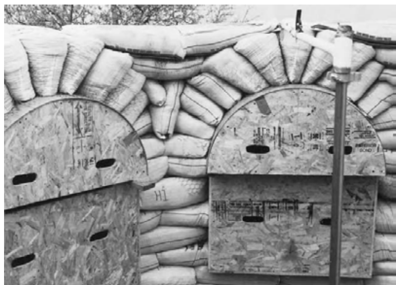
12.21: Plasarea marginii interioare a sacilor-evantai ar trebui să fie aliniată cu compasul.
