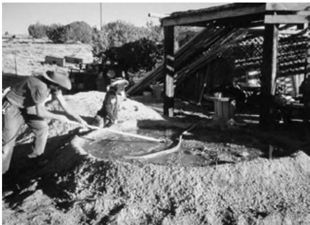
2.9: În unele cazuri, acolo unde apa este o resursă prețioasă, sau trebuie adusă la locație, pământul poate fi inundat și folosit pentru mici baraje, astfel încât apa să se poată infiltra peste noapte.
