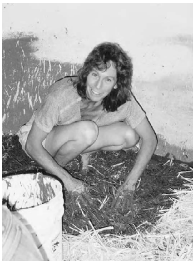
16.5: Amestecarea unui strat izolator bogat în paie poate fi asemănată cu șamponarea unui câine mare cu multă blană.
