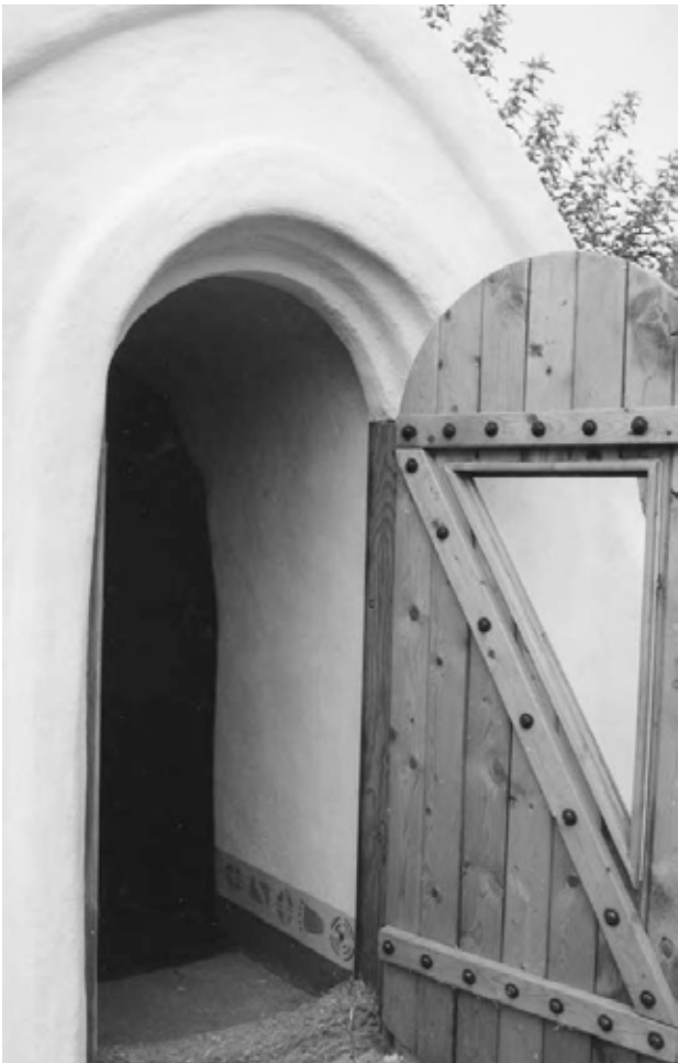
8.14: Ușile arcuite trebuie prinse în balamale în apropierea deschiderii, în așa fel încât să se poată deschide fără a se izbi de arcuirea de deasupra.
