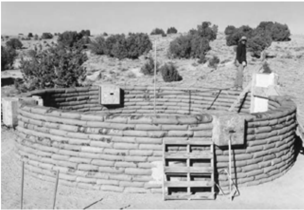
2.14: Sacii din pânză groasă au un aspect frumos și organic, ce poate fi apreciat în timpul construcției.
