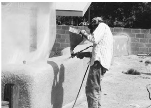
14.16c: Aplicare cu pulverizatorul.
