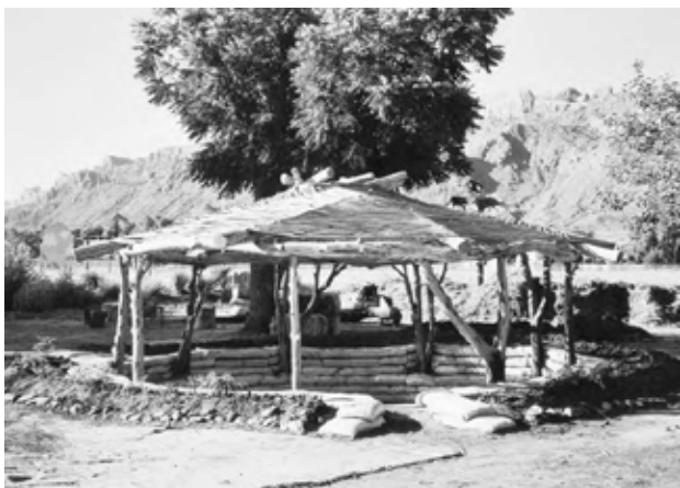
9.25: Inspirat de acoperișul reciproc, Jason Glick a proiectat un foisor cochet, căptușit cu saci de pământ ca bănci de șezut, în Grădina Tineretului din Moab, Utah.
