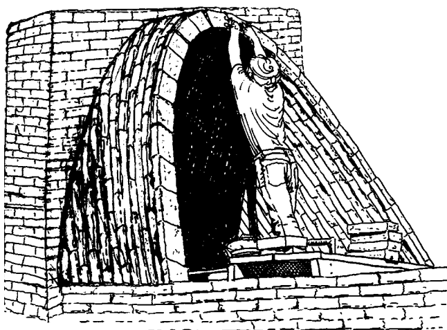
10.14: Zidarii nubieni încorporau curba catenară în construcția bolților înclinate.
