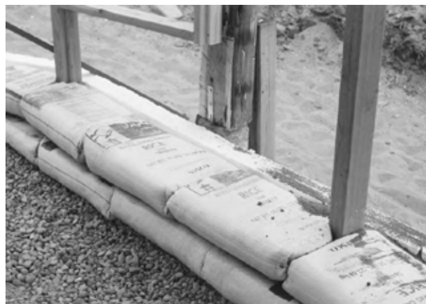
5.16: Cel de-al doilea rând de saci blochează flanșele și înconjoară stâlpii.
