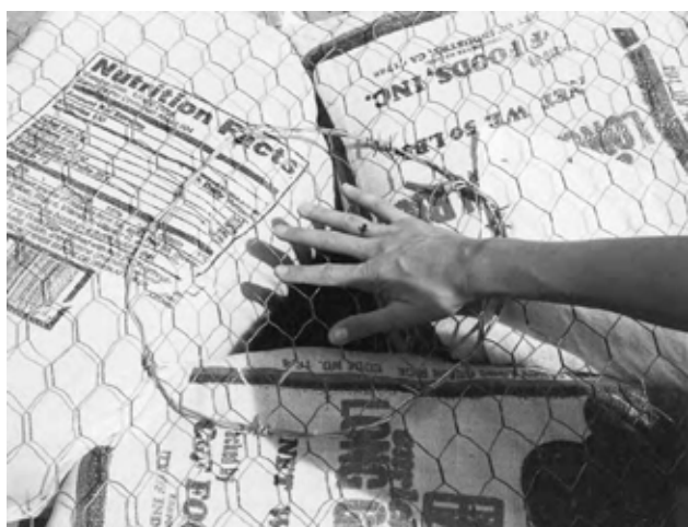
12.32: Un cerc de sârmă ghimpată ține sacii împreună, în timp ce plasa de sârmă oferă o suprafață ușor de apucat pentru aplicarea ulterioară a tencuiei.
