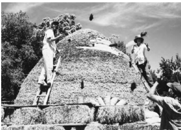
13.2: În cazul tencuielii pe bază de lut rezistente la apă, mărim procentajul de argilă din solul nisipos, îl umplem cu paie lungi, îi dăm forma unei franzele solide și îl aplicăm pe cupolă.
