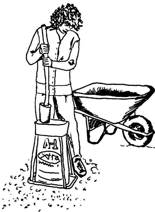
6.7: Compactare cu ajutorul unui sfert de mai.
