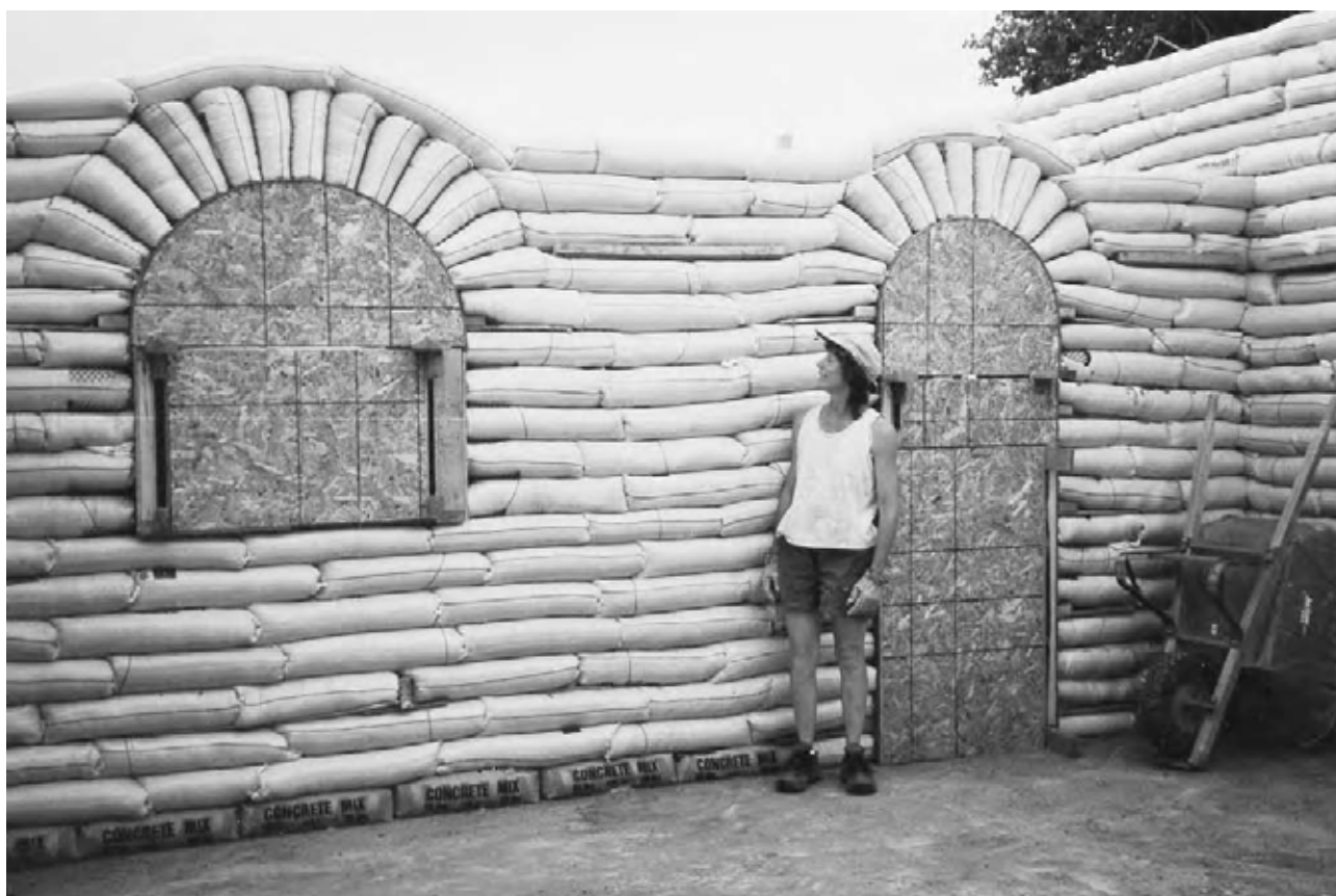
2.22: Cofraj rigid de susținere a golurilor de ușă și de fereastră.
