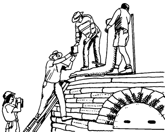
12.28: Munca de colaborare în echipă implică doi oameni pe zid, unul să fie cadrul uman pentru saci și celălalt să încarce. O persoană la sol furnizează pământul și cealaltă, pe scară, devine intermediarul pentru aruncat cutiile cu pământ.
