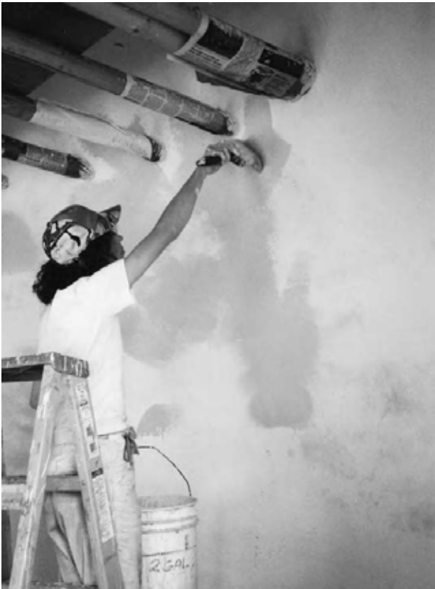
15.7: Vopseaua de lapte uscată va fi cu opt până la zece nuanțe mai deschisă decât atunci când este udă. Vopseaua de lapte poate fi aplicată cu o pensulă sau cu un trafalet, exact ca și vopselele comercializate.
