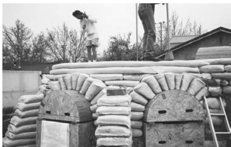
12.22: După compactare, fiecare rând ar trebui să se simtă la fel de tare ca un trotuar.
