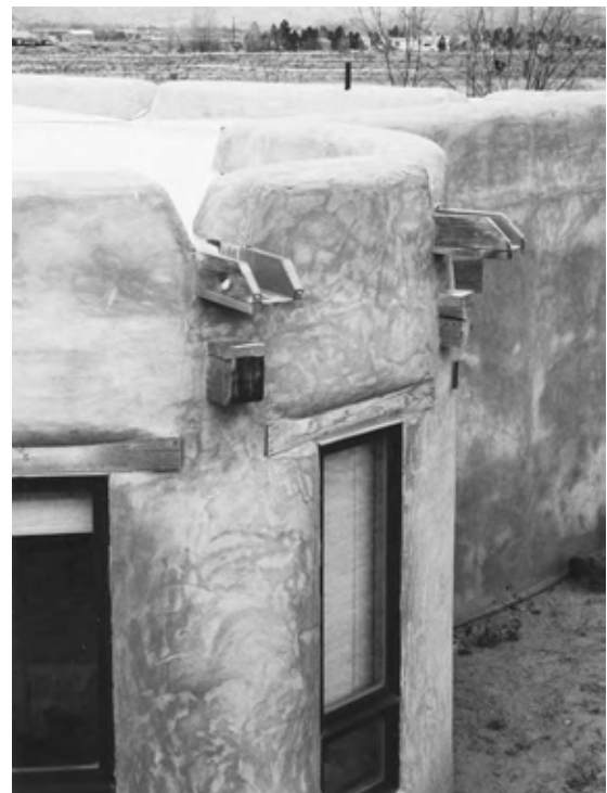
9.14: Acoperiș plat cu parapeti și scurgeri.
