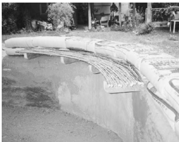
7.12: Rafturi poliță pe un perete curbat învelit cu bambus și/sau crengi.
