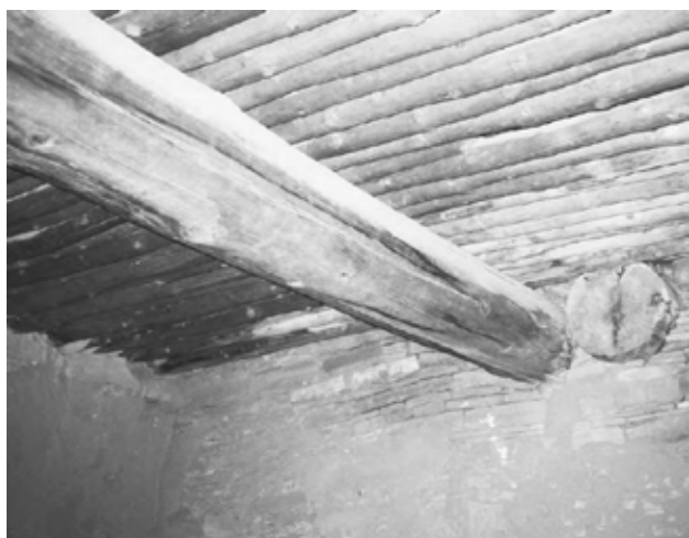
9.9: Pe această structură Anasazi din Chaco Canyon, New Mexico, se observă șipci și traverse originale, pe piatră și pereți din pământ, încă intacte după 1.000 de ani. Oare o casă modernă va rezista la fel?
