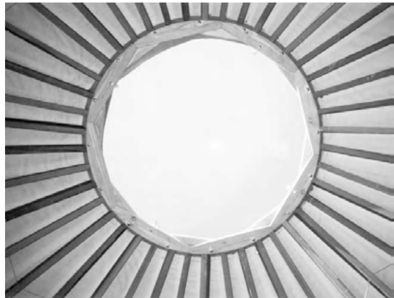
9.21: Privind de jos, din interior, la inelul de compresiune pentru un acoperiș de iurtă.
