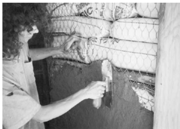
15.5: Tencuiala fără fibră se aplică repede și umple bine toate golurile dintre rândurile de saci, până când se așază la același nivel cu plasa de sârmă.
