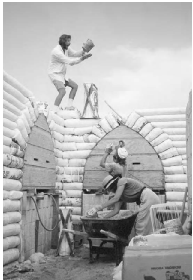
3.10: Uitați-vă unde vreți să ajungă cutia, faceți-i puțin avânt și aruncați-o în sus.
