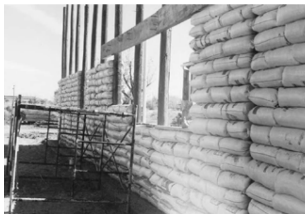
5.18: Întrucât stâlpii erau destul de înguști, sacii i-au înghițit pe măsură ce au fost așezați în jurul lor.
