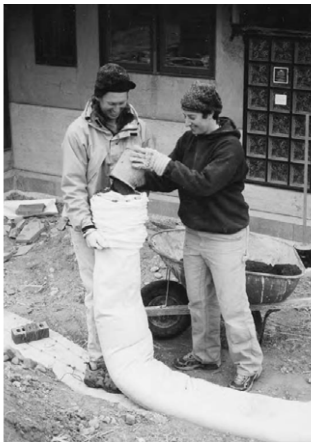
3.24: Un tobogan pentru tuburi se comportă ca un manșon pe care se rulează tubul în lungime, la fel ca o pâlnie pe unde intră pământul.
