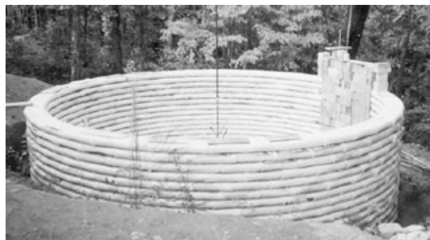
5.7: Forma supremă de contrafortuire este un cerc complet. MARLENE WULF
