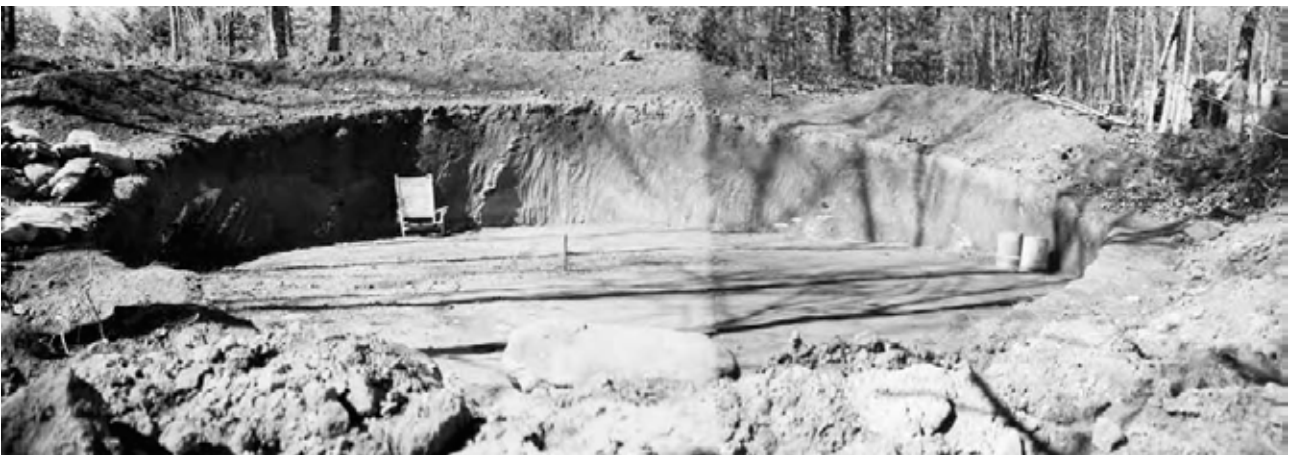
2.5: Deși s-a muncit intensiv, această locație atent excavată nu a deranjat foarte mult vegetația înconjurătoare, punând, totuși, la dispoziția proprietarei pământul necesar construcției.
