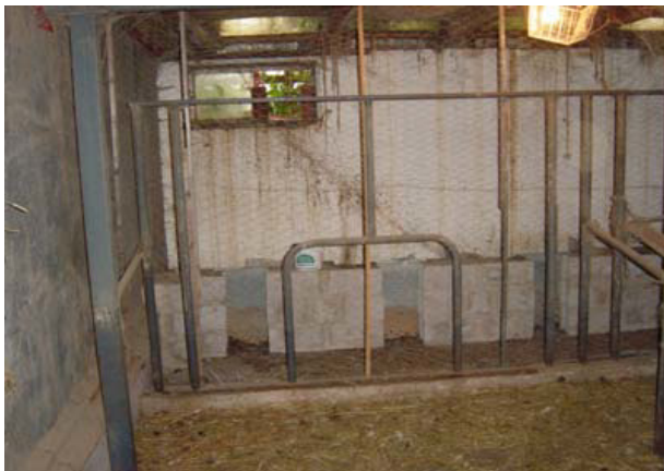
Fig. C3: Cutiile din blocuri de zgură ușoară și mortar se află în spatele cotețului de găini
